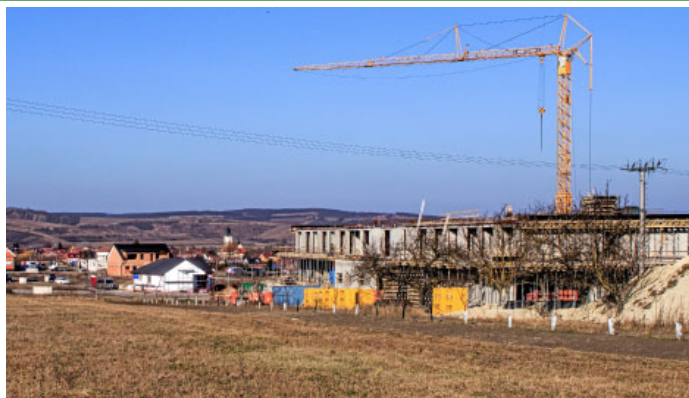
Ostrovec – bývalé JZD; budování nové obytné zóny
